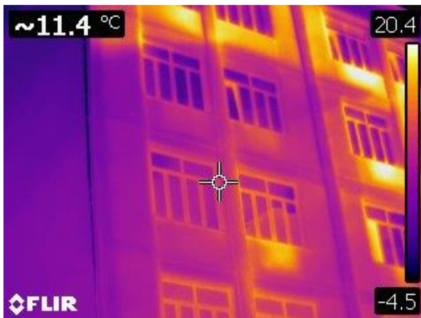
Figura 2.3 – Immagine termografica facciata
