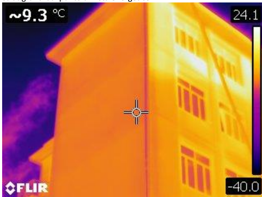
Figura 2.2 – Immagine termografica facciata - solaio interpiano
